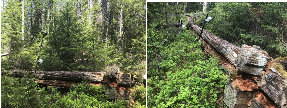
Fig. 16–17. Fähuslämningar. Raka knutar och runda stockar tyder på sent 1700 eller 1800-tals timring.
